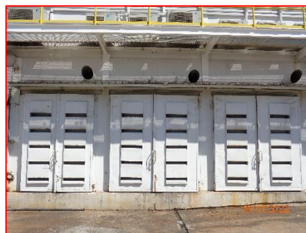
ภาพที่ 2.1-14 วัสดุปรองและห้องครอบ/ฝาครอบ เครื่องจักรที่มีเสียง
