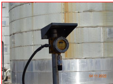
ภาพที่ 2.1-31 ระบบตรวจจับการรั่วไหลของฟอर्मัลดีไฮด์ (Fixed Gas Detector)
