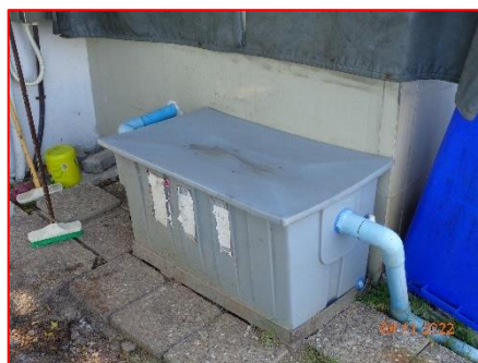
ภาพที่ 2.1-6 ระบบบำบัดน้ำเสียเบื้องต้น
