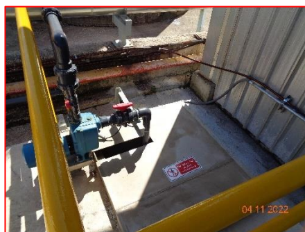
ภาพที่ 2.1-41 บ่อรองรับน้ำฝนปนเปื้อน
