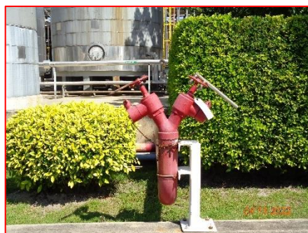
ภาพที่ 2.1-34 ระบบดับเพลิงบริเวณคันคอนกรีตรอบถัง เก็บฟอर्मัลดีไฮด์
