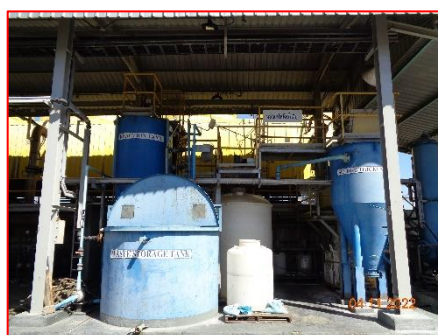
ภาพที่ 2.1-6 ระบบบำบัดน้ำเสียเบื้องต้น
