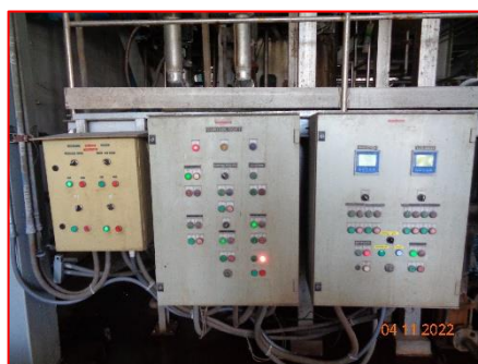
ภาพที่ 2.1-4 จอแสดงผล (Display) ของระบบควบคุม Scrubber
