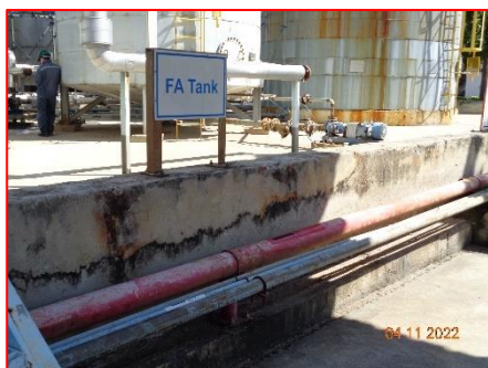
ภาพที่ 2.1-33 คันคอนกรีตรอบถังเก็บฟอर्मัลดีไฮด์
