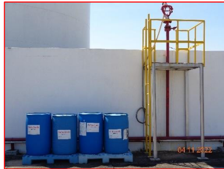
ภาพที่ 2.1-38 ระบบดับเพลิงบริเวณคันคอนกรีต รอบถังเมทานอล
